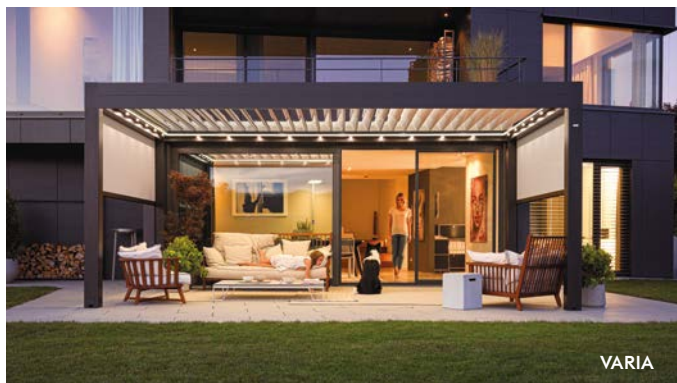
11 LED strips sur le pourtour
